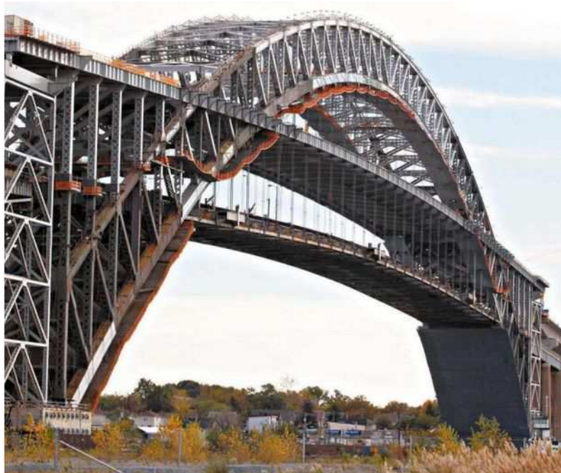
Elevação da Ponte Bayonne demanda investimentos de US$ 1,3 bilhão deve ser concluída no final de 2017 (Foto: Fernanda Luz/A Tribuna)
