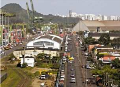
Obra vai revitalizar a Av. Mário Covas
